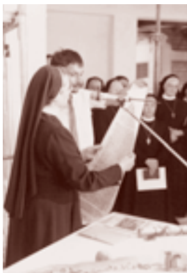
Die neue Grundsteinurkunde wird eingelegt
