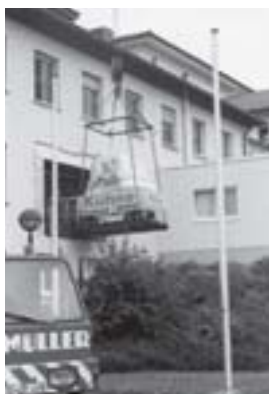
Kraftakt: die Mauer muss durchbrochen werden für den Kernspintomographen
