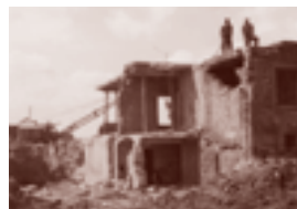
Torso: Der Abbruch
